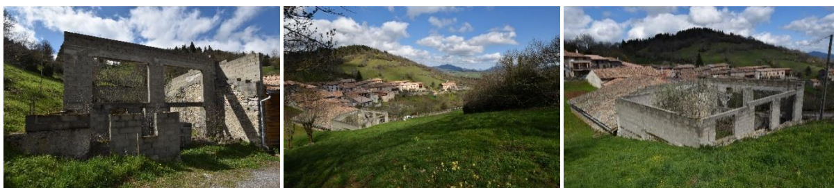
La construction inachevée sur la parcelle – Cliché : Mairie de Belcaire, juin 2021.
